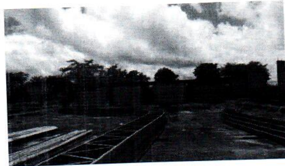
Foto 16 e 17 – Arcos metálicos armazenados de forma irregular
